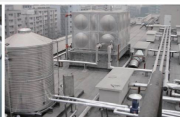
Realizzazione di serbatoi
