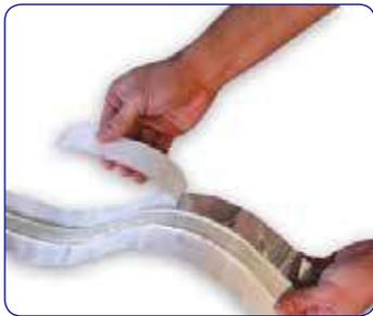
Rimuovere la copertura posteriore del nastro da ambo le parti. Avvolgere delicatamente i bordi posteriori adesivi del nastro e spingere verso l'esterno il tessuto in fibra di vetro
